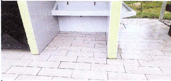
Foto 3: COLOCACION DE PISO Y LAVADEROS
