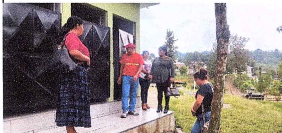
Foto 5: PINTURA DE PUERTAS DE SANITARIOS
